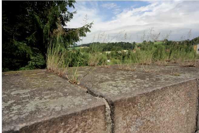
Detail der von KZ-Häftlingen erbauten Schlepplahnbrücke in St. Georgen an der Gusen.
